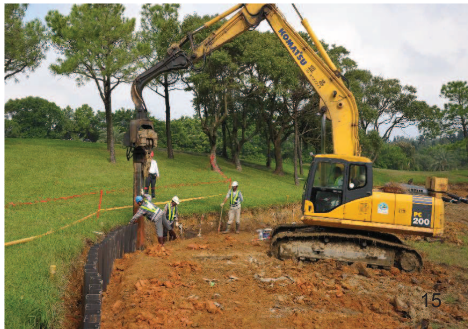
步驟八：以打樁機依所需深度打入土層
