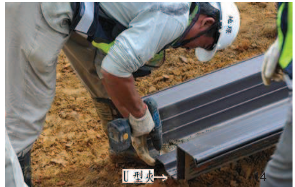
步驟四：底部以U型夾固定
